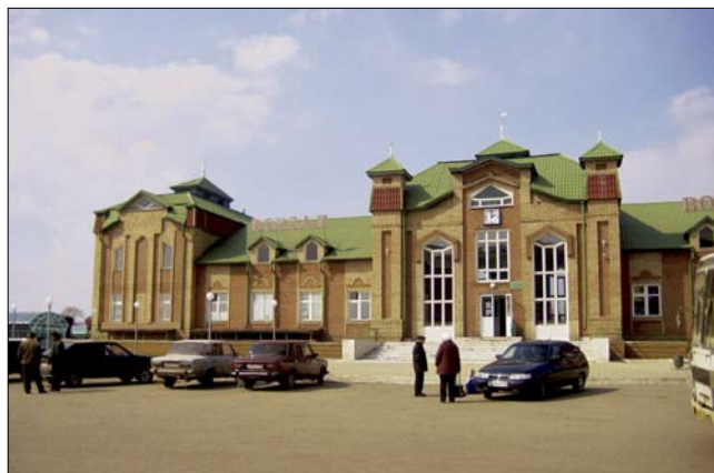
Железнодорожный вокзал. г. Буинск Railway station, Buinsk city
